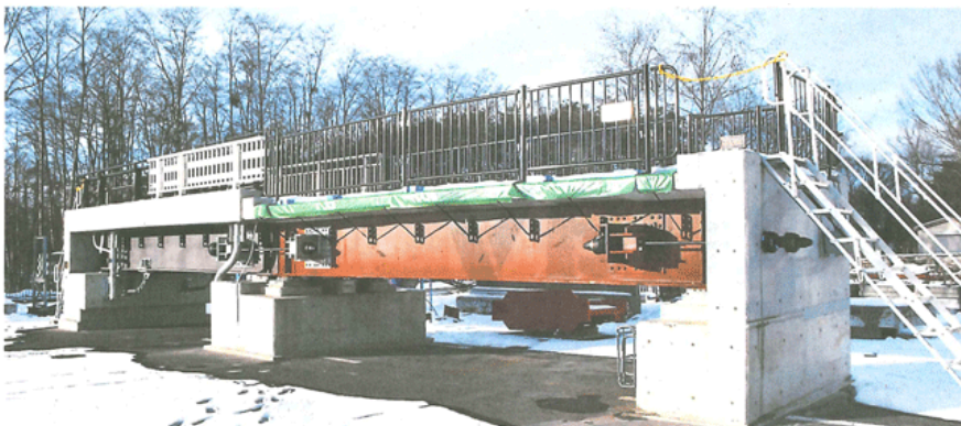
八戸工業大学が整備した「橋梁メンテナンス体験施設」 〓八戸市
